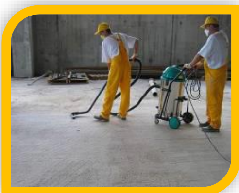
Odkurzanie podłoża po szlifowaniu
