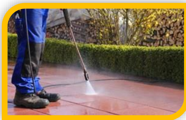
Oczyszczanie wodą pod ciśnieniem, np. Kärcher
