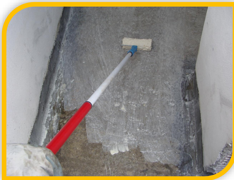
Gruntowanie powierzchni betonowej
