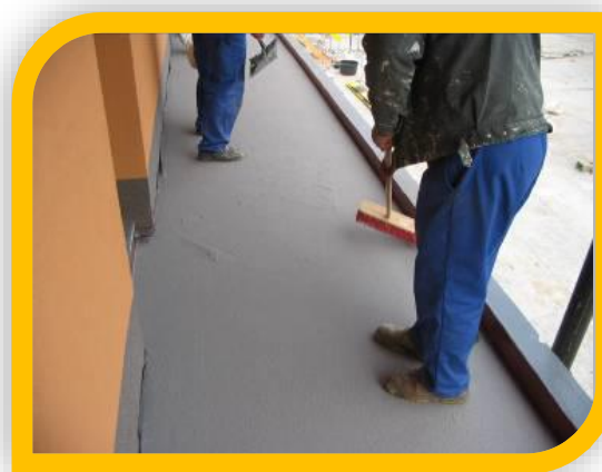
Usuwanie nadmiaru kruszywa
